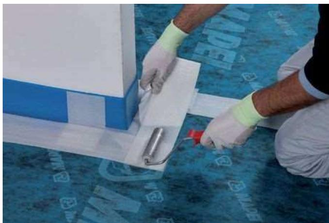
Per i piani di Calpestio all'interno delle parti abitate, **verrà posto in opera e risvoltato su ogni parete un tappeto smorzante acustico tipo "Fonostop Duo" a formazione del piano di posa del riscaldamento a pavimento e massetto di pavimentazione.**
