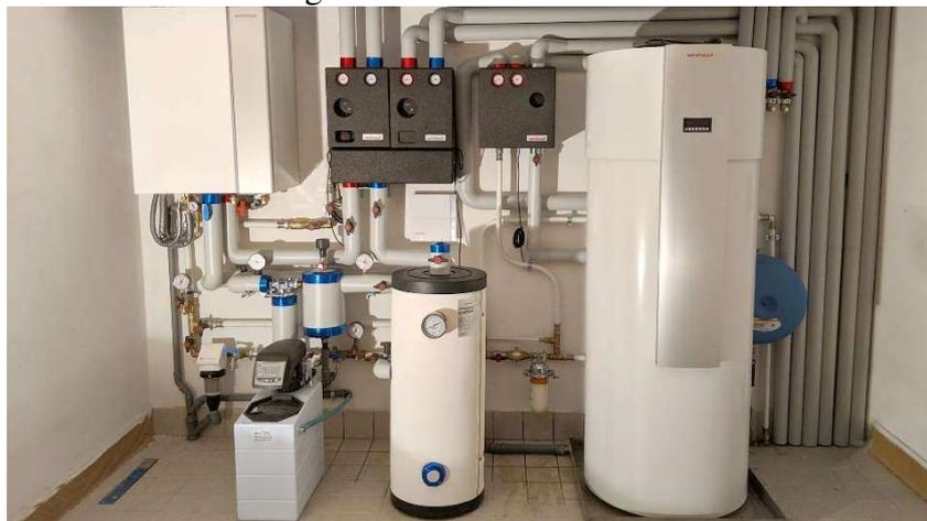
Tutto l'impianto sarà isolato in ottemperanza alla normativa e per l'ottenimento della certificazione energetica prevista dell'abitazione, inoltre, l'impianto sarà predisposto per l'eventuale installazione di Addolcimento e trattamento dell'acqua e servito da impianto fotovoltaico autonomo per l'ottimizzazione dei consumi e abbattimento dei costi in relazione al periodo di produzione dell'acqua calda sanitaria, su base annua, come richiesto dalla norma vigente.
