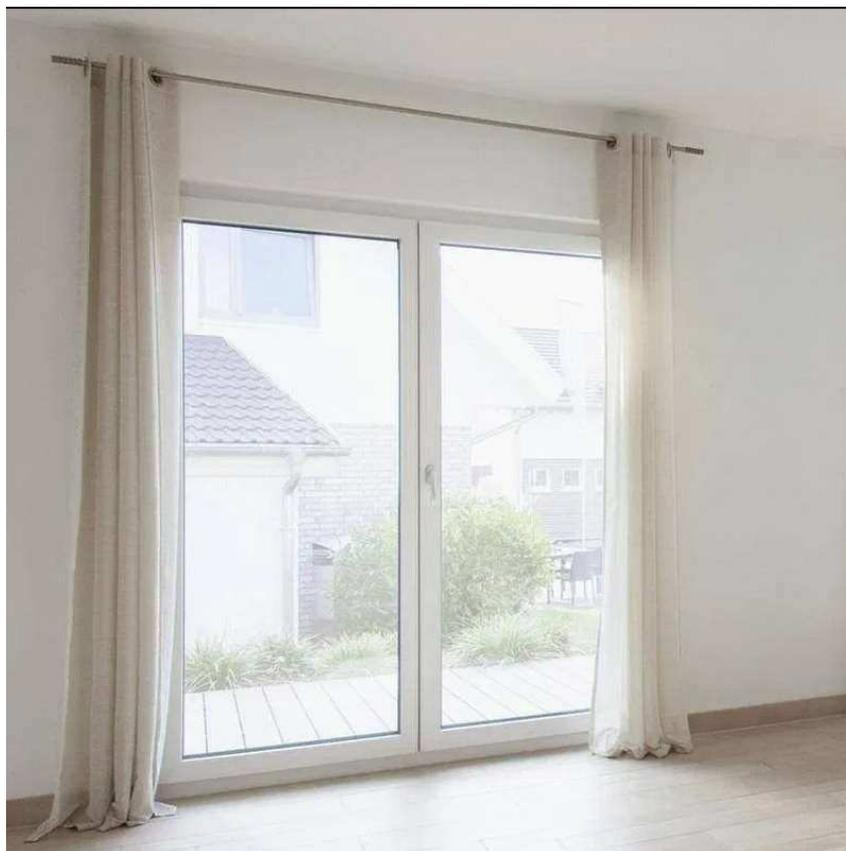
Tutti i serramenti esterni saranno ad ante battenti, con apertura ad anta ribalta, completi di ferramenta e copri cerniere in alluminio o pvc colore argento.
