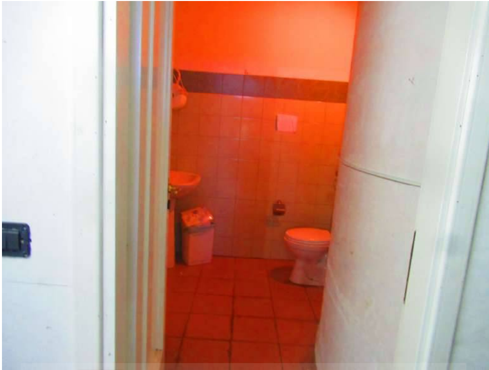
Foto n ° 91 – Piccolo wc al piano S1. –
