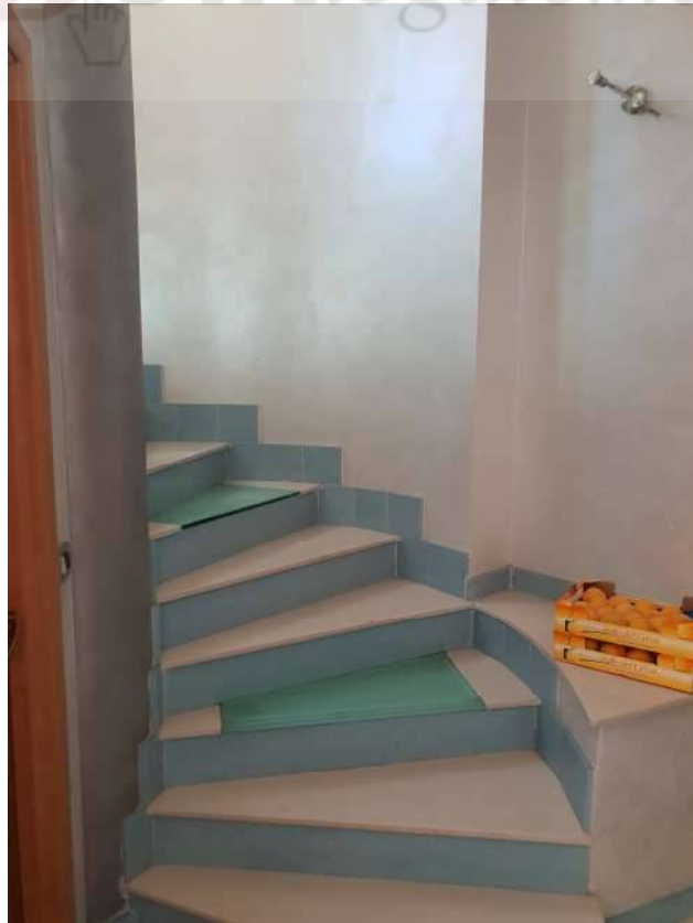
Foto n ° 8 –Scala condominiale conducente dal p.t. ai piani superiori -
