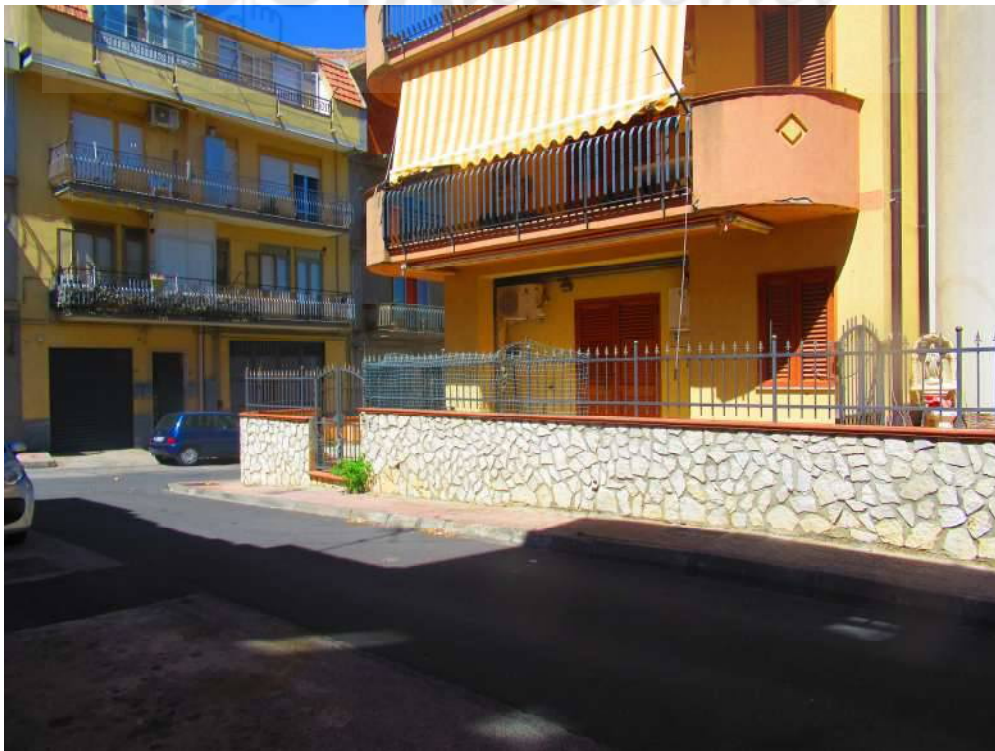
Foto n ° 4 – Vista delle due vie Letizia Milani e Centuripe – particolare intersezione . –
