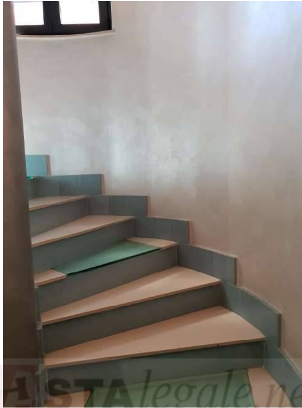
Foto n ° 37 – Scala condominiale conducente al piano secondo -
