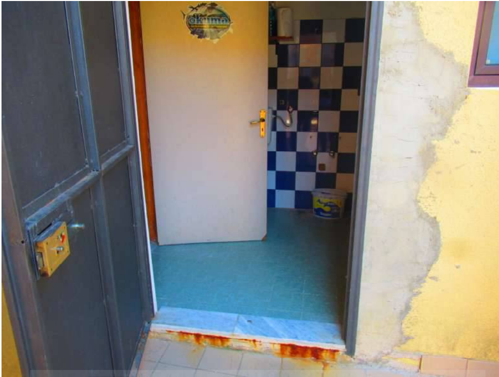
Foto n ° 119 – Ingresso sub 10. –
