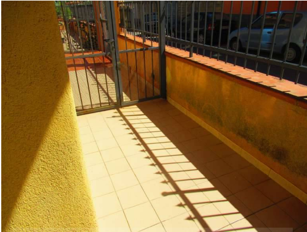
Foto n ° 103 – Spazio esterno. –
