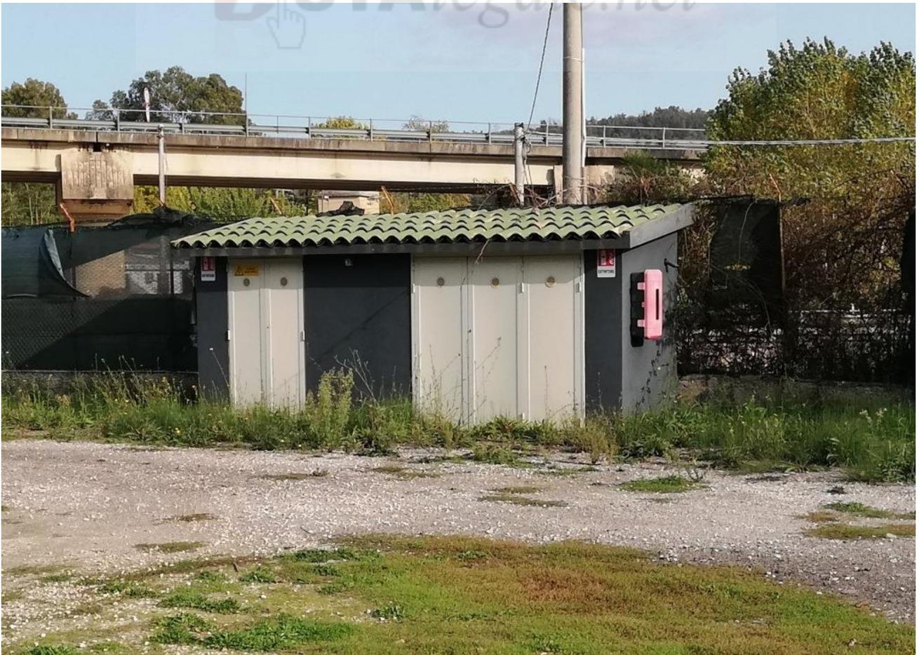
**Foto 12 – box prefabbricato adibito a cabina di consegna dell'energia elettrica**
