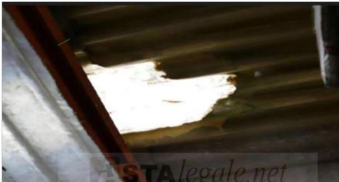
*Particolare fotografico parte di copertura degradata in lastre di fibrocemento-amianto*
