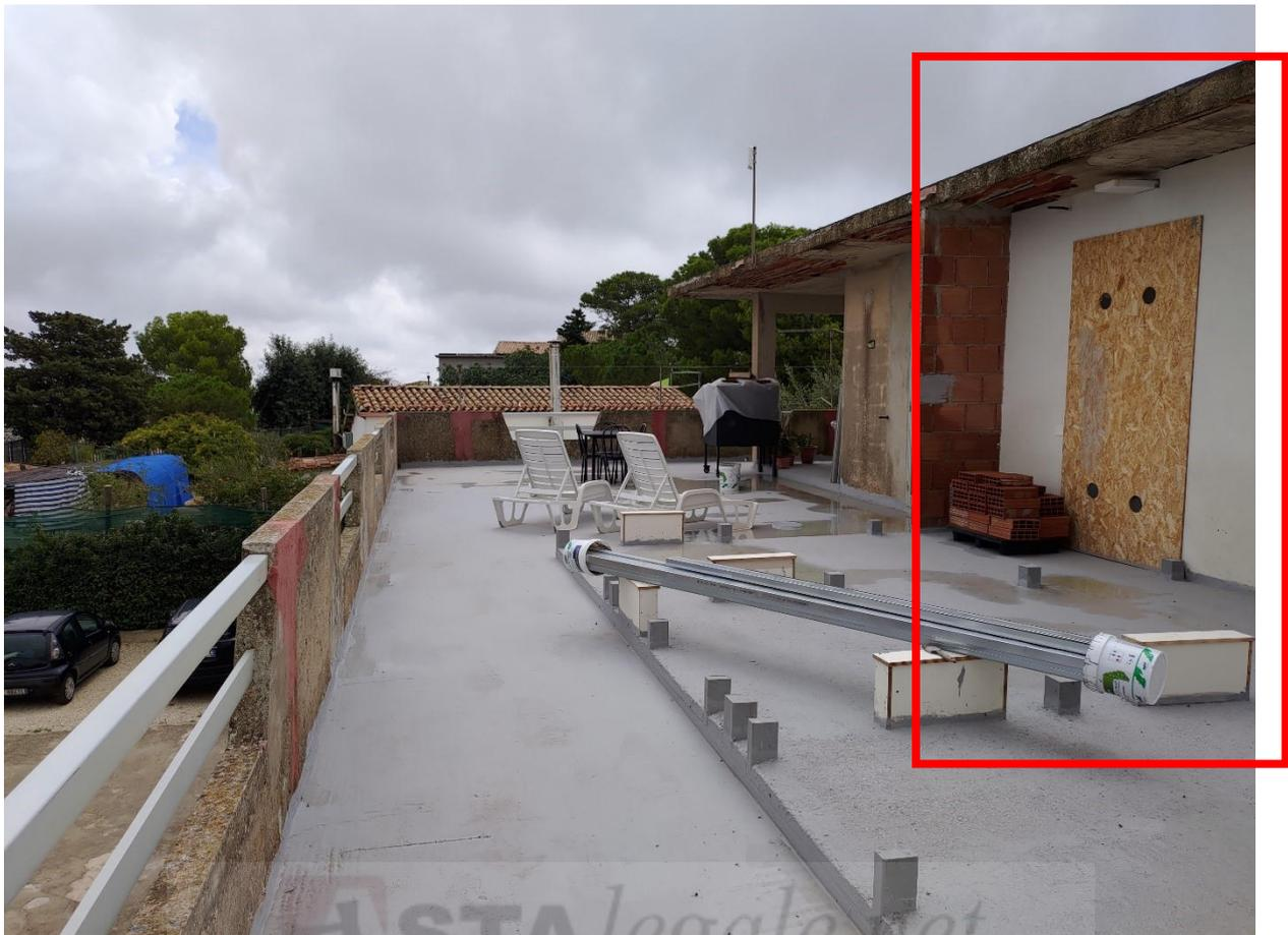
Foto 7 – Terrazza (la parte indicata con tratto rosso è realizzata in legno e deve essere riportata allo stato di progetto della C.E. (immobile 1). (nella terrazza vi sono predisposti degli elementi per realizzare nuove strutture abusive)
