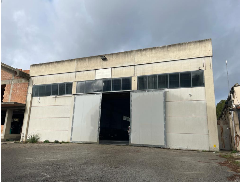
Foto 1: Prospetto principale (lato sud-est)
