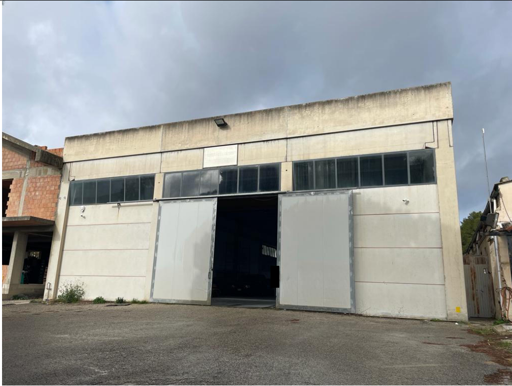
Foto 1: Prospetto principale (lato sud-est)
