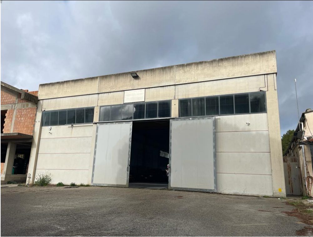
Foto 1: Prospetto principale (lato sud-est)
