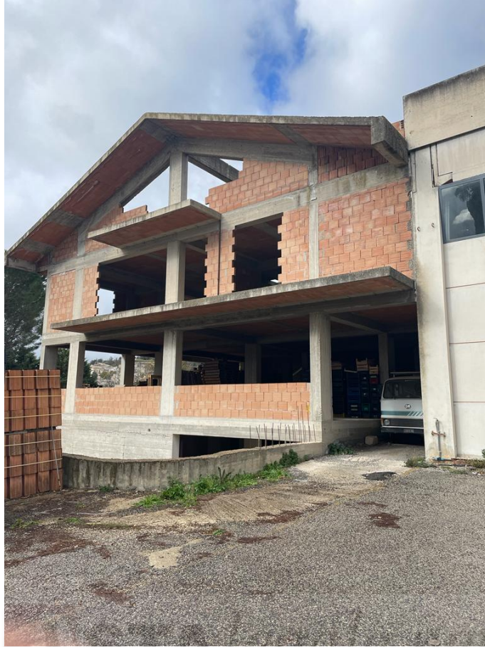
Foto 1: Immobile di cui fa parte il lotto 2
