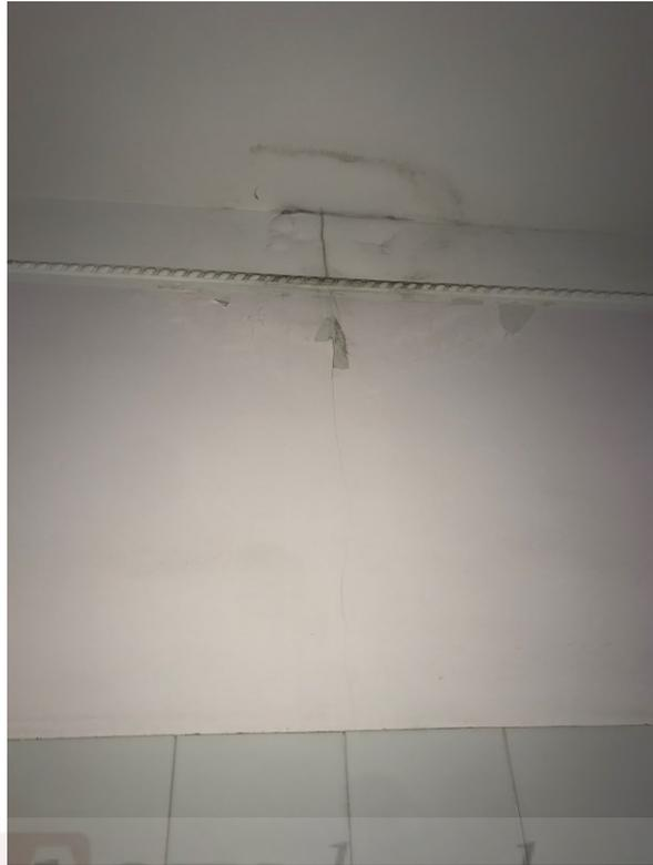
***Foto n. 17 – infiltrazione umidità bagno solaio***
