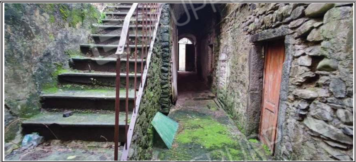
Foto n. 7 – Ingresso e scale comuni al piano terra
