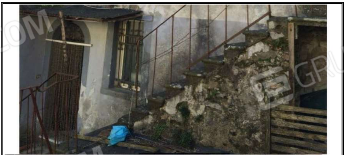
Foto n. 18 – Terrazza e latrina comune
