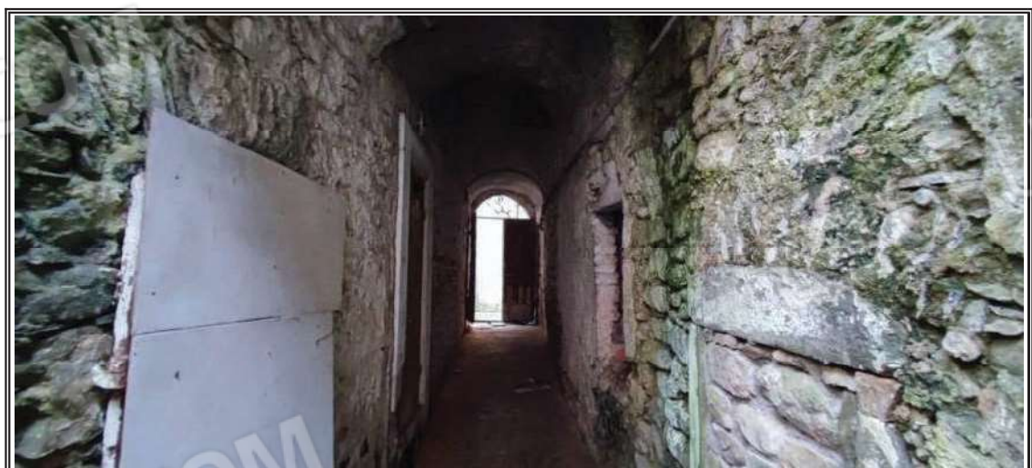
Foto n. 6 – Ingresso comune al piano terra
