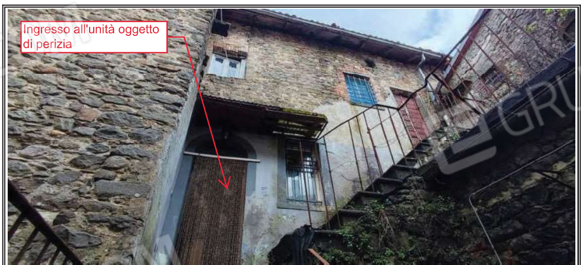
Foto n. 9 – Ingresso all'appartamento oggetto di stima
