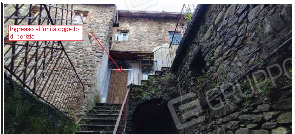
Foto n. 8 – Scale comuni di accesso al piano primo
