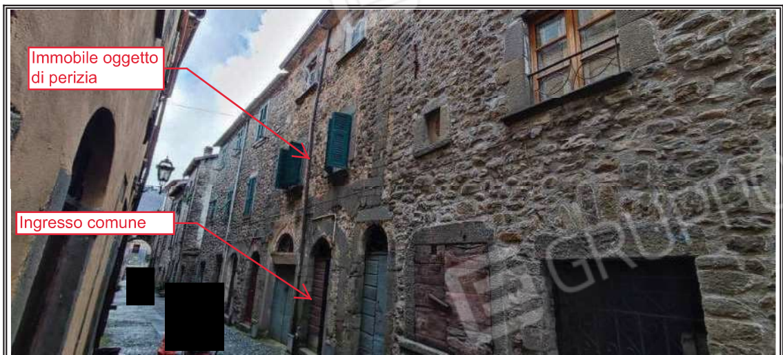
Foto n. 2 – Vista del fabbricato da Via Borgo – da EST
