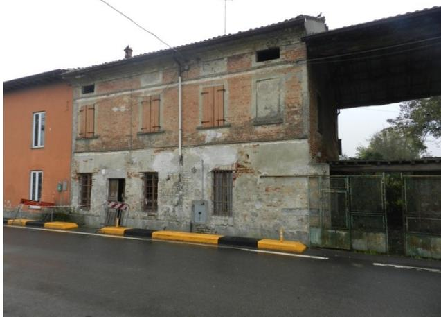
I solai interpiano sono in legno con alcuni plafoni controsoffittati le tinteggiature sono vetuste ; il solaio di copertura è a tetto a doppia falda in legno con manto in coppi , un tratto di gronda sta cedendo.
