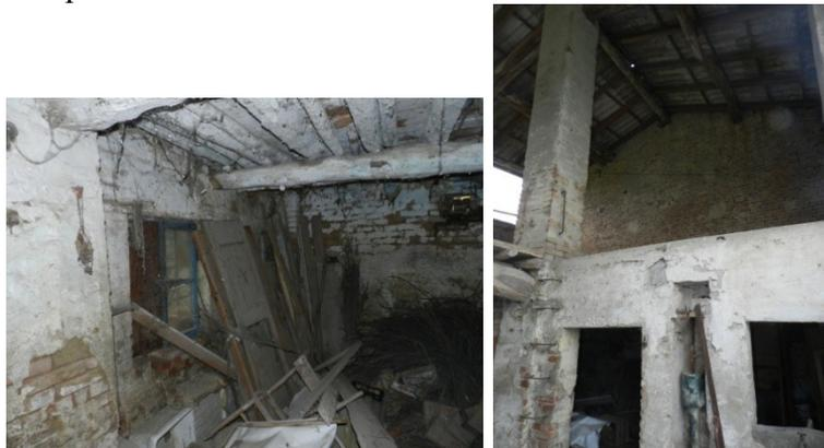
La porzione ha la struttura portante verticale in mattoni pieni e gli orizzontamenti in legno , la copertura a tetto è in legno con manto in lastre di fibrocemento con amianto (Eternit) e coppi .
