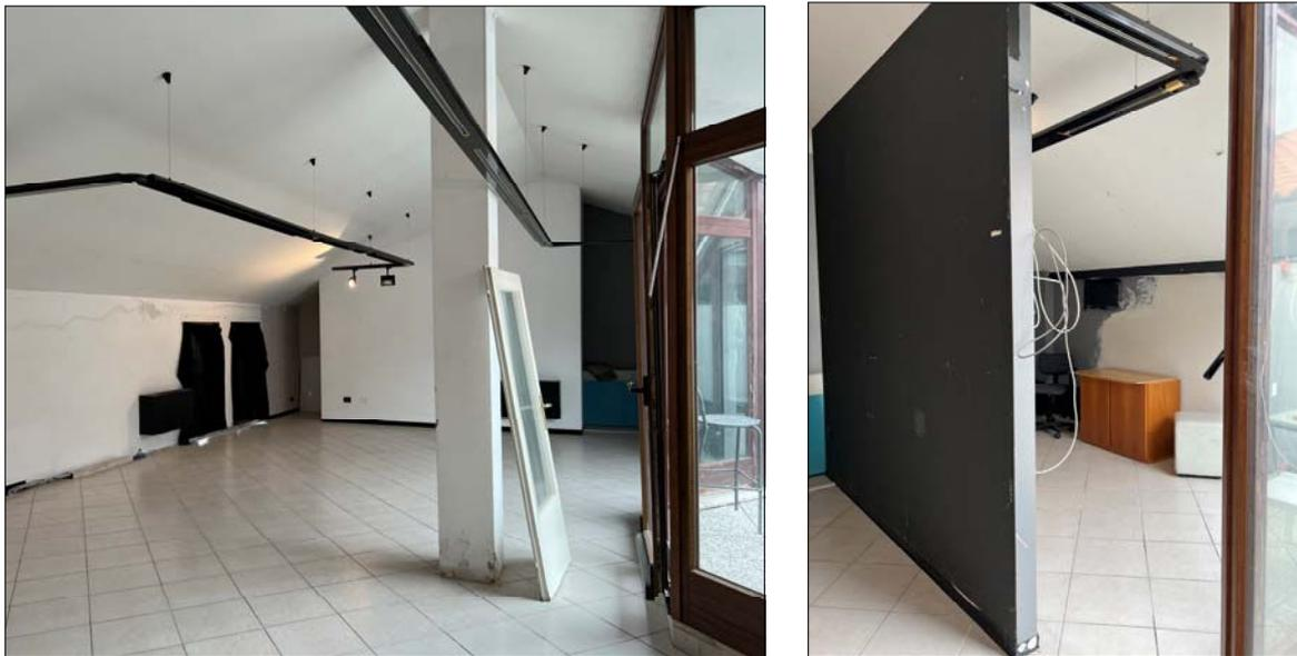
Vista delle due tramezze in cartongesso a divisione del laboratorio
