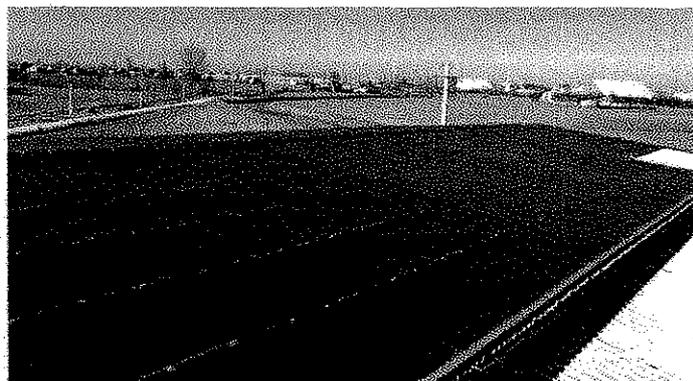
L'intervento si è configurato come l'installazione di pannellature fotovoltaiche in silicio amorfo sulle due falde Est/Ovest di un tetto a doppia falda. La conversione elettrica da corrente continua a corrente alternata è di tipo multi-stringa con tre inverter.
