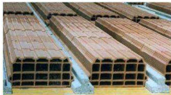
Struttura orizzontale bidimensionale piana caricata ortogonalmente al proprio piano che svolge il compito di ripartire i carichi sulle travi e dalle travi ai pilastri.
