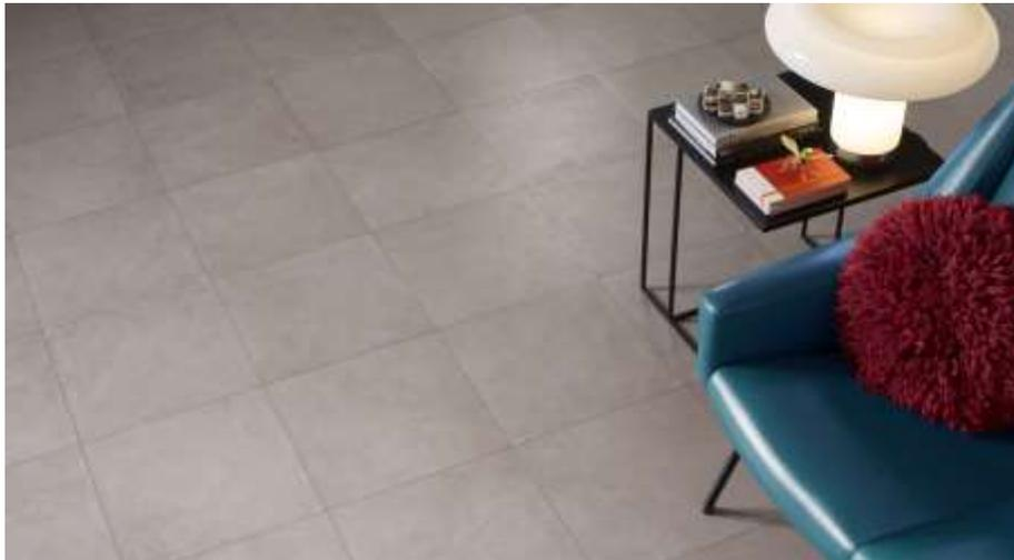
Le pavimentazioni interne di tutti gli ambienti sono previste in piastrelle di ceramica monocottura, dotate di scarsa porosità, durezza e da un'elevata resistenza all'usura. Inoltre le pareti dei servizi igienici verranno rivestite con piastrelle di ceramica.
