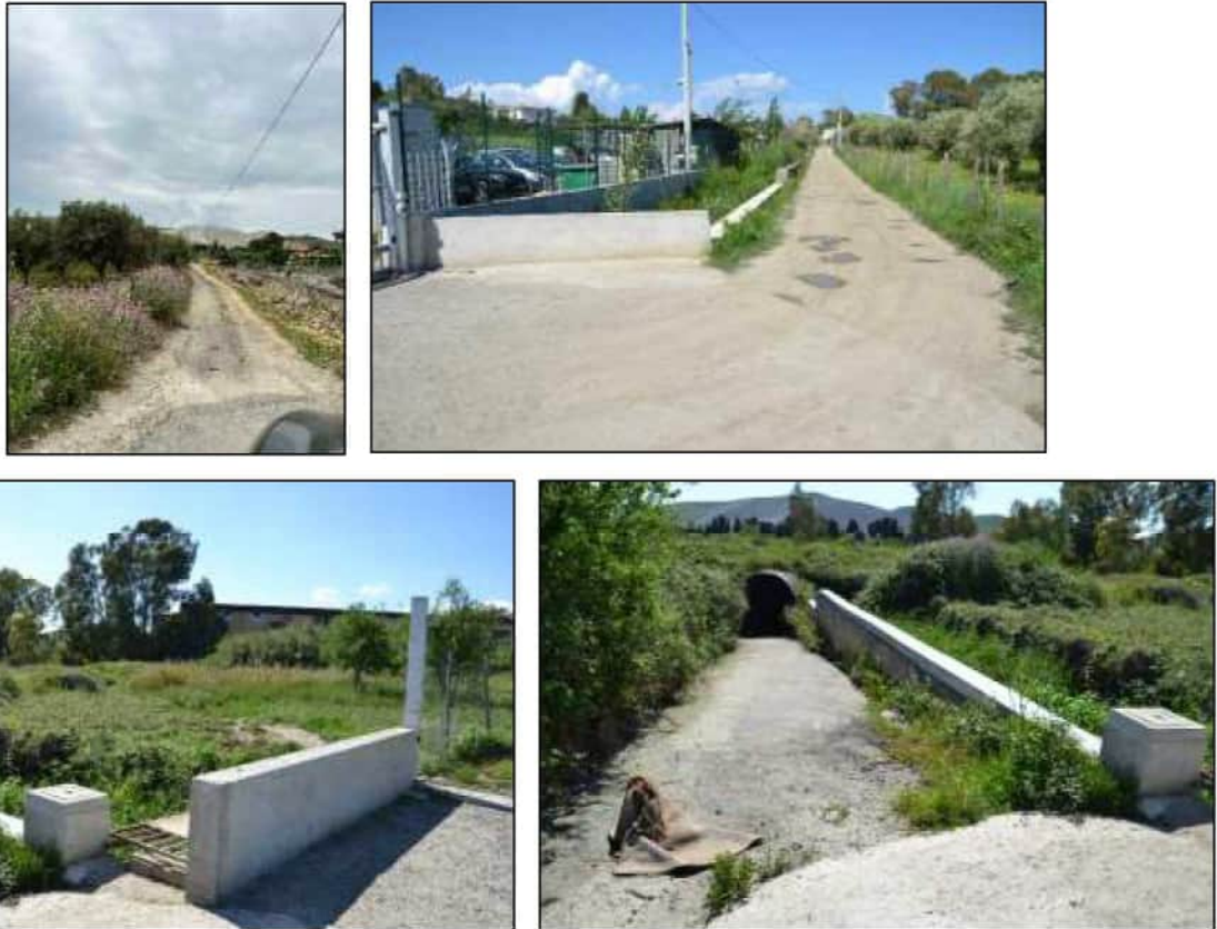
Figura 82 - Canale di bonifica posto sul lato SUD del BENE S2
