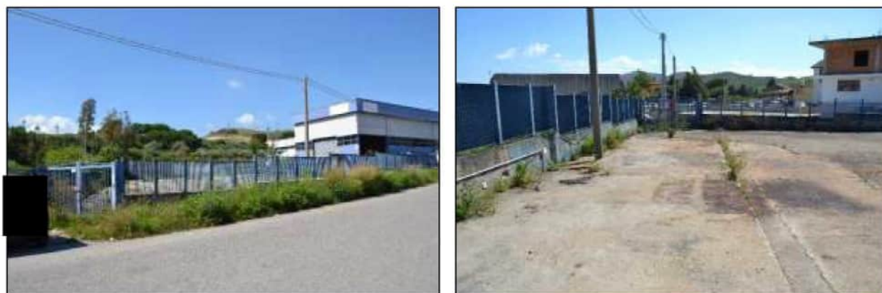
Figura 77 – Palo della corrente elettrica insistente sulla particella 918 – BENE S1
