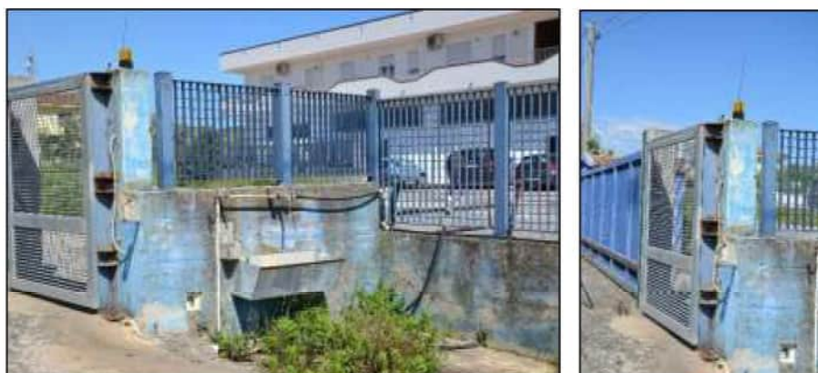
Figura 76 – Punto di approvvigionamento idrico attualmente dismesso – BENE S1
