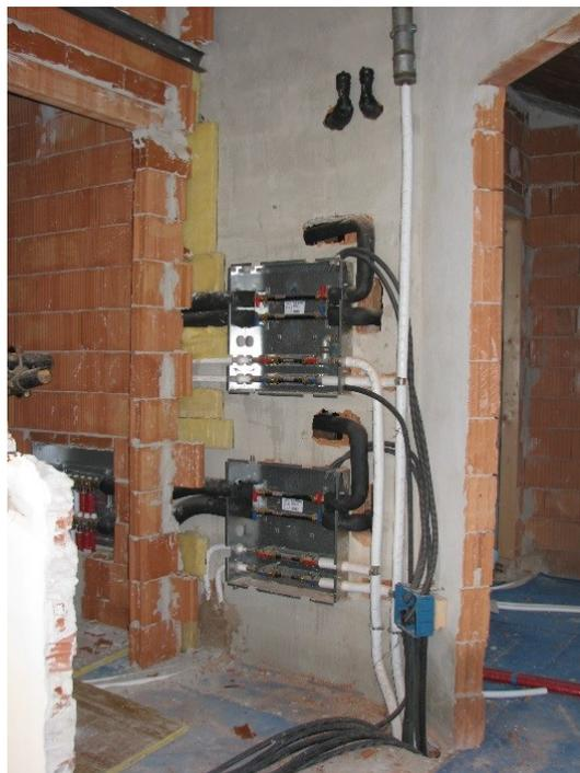
A valle di tali armadietti, all'interno dei relativi alloggi, si trova un collettore al quale accedono tutte le tubazioni dei corpi scaldanti. Per i collegamenti tra il collettore ed i corpi scaldanti sono state utilizzate tubazioni multistrato coibentate, senza giunte o saldature. All'interno degli appartamenti i terminali riscaldanti e raffrescanti, installati in ogni camera con l'eccezione dei bagni, saranno della casa costruttrice OLIMPIA SPLENDID, tipo Bi2 slim.
