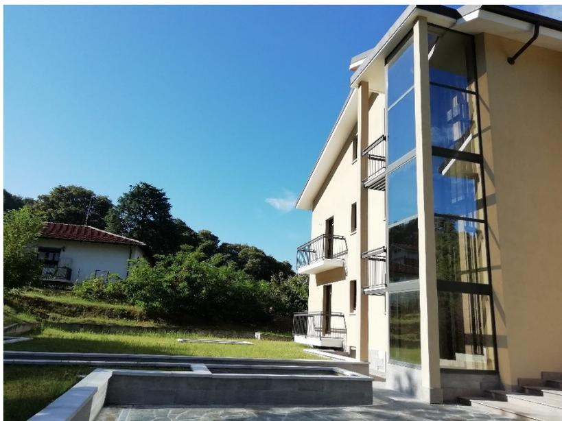
L’impianto è stato realizzato dalla ditta SDL Ascensori di Torino e trattasi di un ascensore senza locale macchine, con argano elettrico tipo SASSI G200 posizionato sulla testata del vano corsa, capienza di n. 6 persone, velocità di 1 m/sec.
