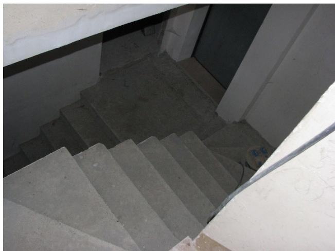
in c.a. con due rampe di gradini e due “fazzoletti”. La nuova scala prosegue poi fino al disimpegno dello sbarco a terra dell’ascensore che dà accesso alle autorimesse.
