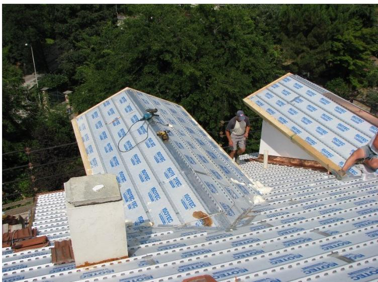
ISOTEC è un pannello in poliuretano espanso dalle elevatissime prestazioni isolanti ( $\lambda d = 0,022$ ), con correntino in acciaio integrato, studiato per supportare qualsiasi tipologia di tegola e al tempo stesso consentire l'attivazione della ventilazione del sotto-manto, migliorando le prestazioni energetiche e le condizioni di benessere abitativo.
