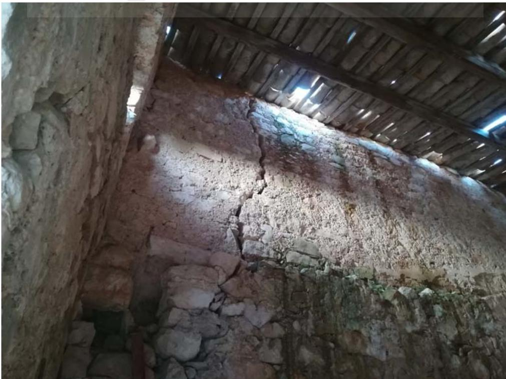
Foto 14 – interno b) particolare crepa e soffitto - p.lla 272 sub 1 fg 36 di Comiso – c.da Crocilla
