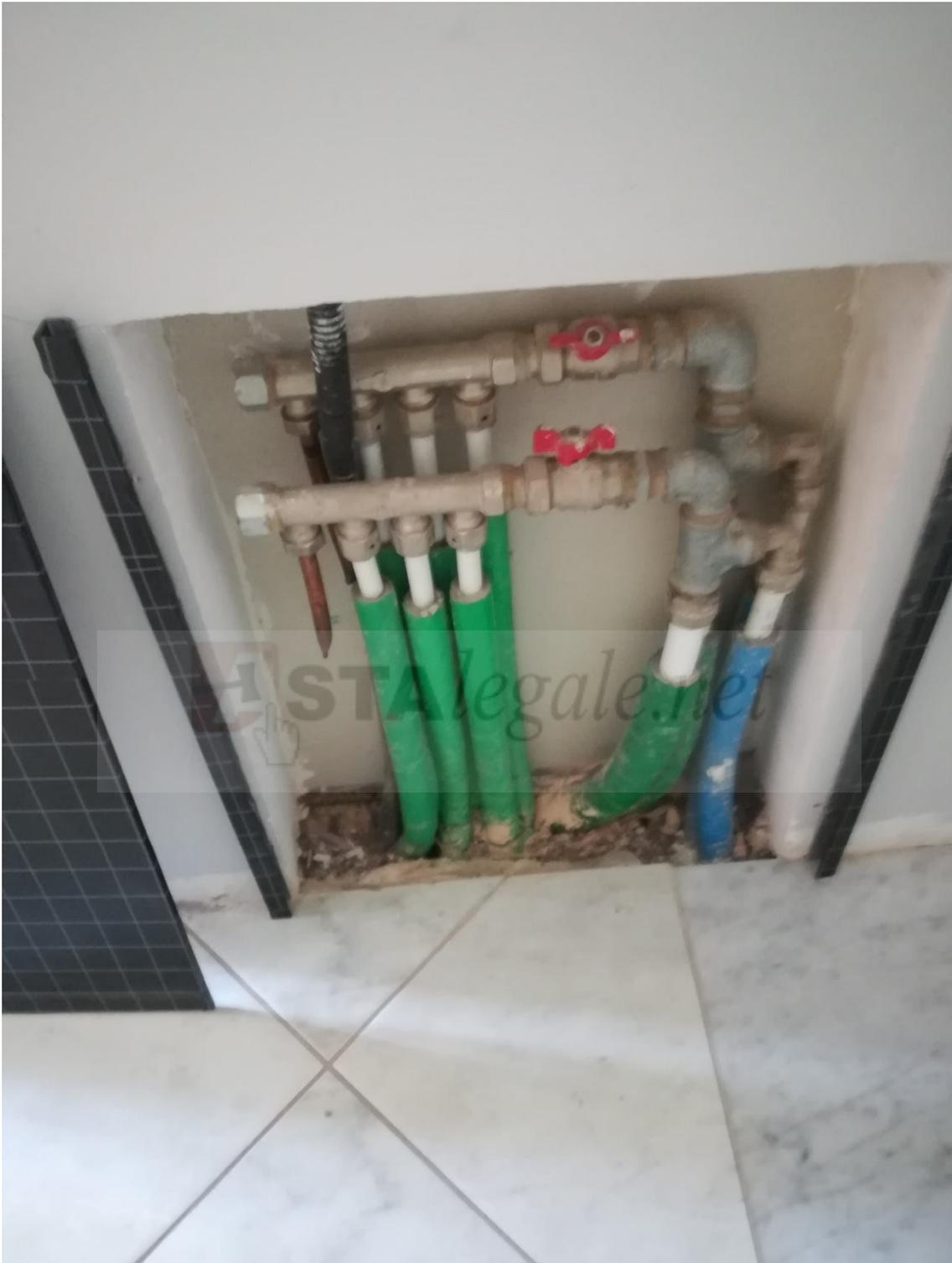
Foto 15: Piano primo rispetto Via Prestifilippo. Particolare collettore impianto termico
