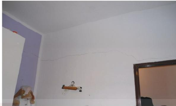
Figura 2. Fessurazione orizzontale nella tramezzatura interna
