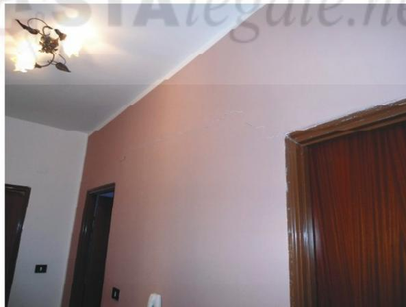
Figura 3. Fessurazione orizzontale nella tramezzatura interna
