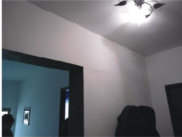
Figura 4. Fessurazione orizzontale nel muro portante centrale
