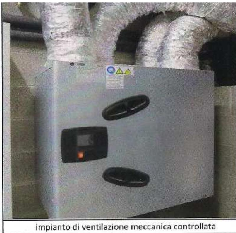
Di ditta primaria. Verrà eseguito l'impianto completo di canalizzazioni incassate in condotto flessibile per aria di mandata e ripresa.
