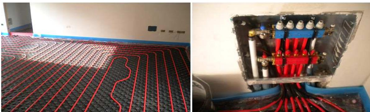
Con integrazione idraulica, con sistema a pannelli radianti eh 50 spessore totale 52 mm
