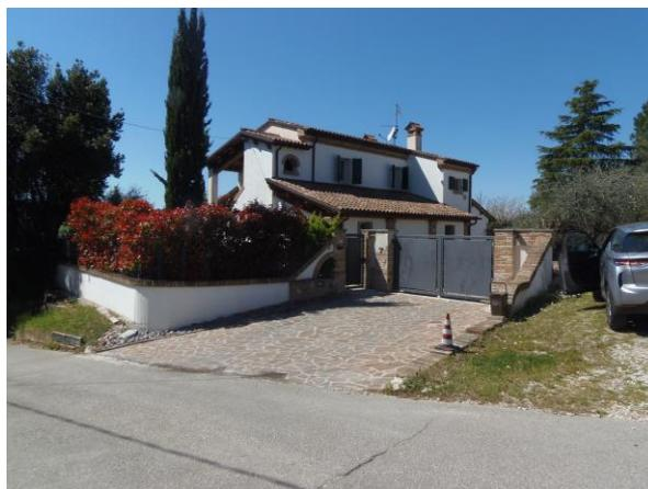
Dispone di un'ampia area cortilizia delimitata con muretto e rete metallica, cancello carrabile pedonale in ferro sorretti da colonne in muratura con inserti intonacati. Si segnala che sul lato fronte strada è presente uno smottamento del terreno.
