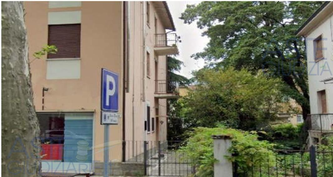
L'edificio, costruito alla fine degli anni cinquanta, si sviluppa su tre piani fuori terra ed uno interrato con due vani scala; la struttura portante è in muratura di mattoni pieni con solai in latero-cemento, le pareti divisorie sono in laterizio forato da cm 10 di spessore, il tetto ha il manto di copertura in tegole, converse e pluviali in rame, le facciate sono tinteggiate, il tutto in buono stato di conservazione.
