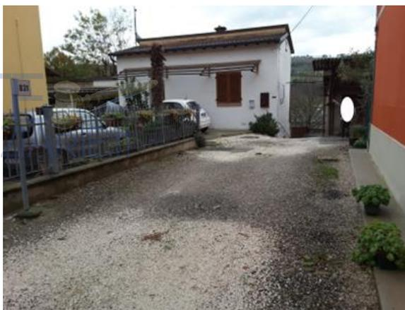
Il fabbricato si sviluppa su due piani, di cui uno parzialmente interrato (da un lato); ha struttura portante di tipo misto, copertura a due falde sfalsate con struttura in latero cemento e soprastante guaina bituminosa completa di manto in laterizio; i canali di gronda ed i pluviali sono in rame.
