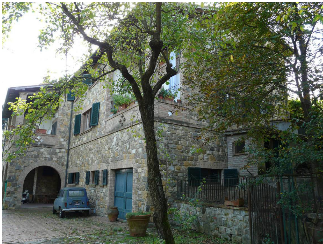
28-prospetto tergale del fabbricato
