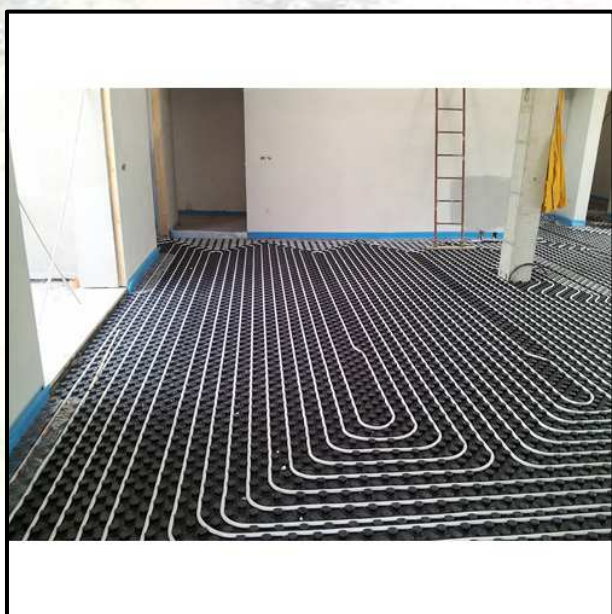
Figura 10: Esempio di impianto di riscaldamento a pavimento
