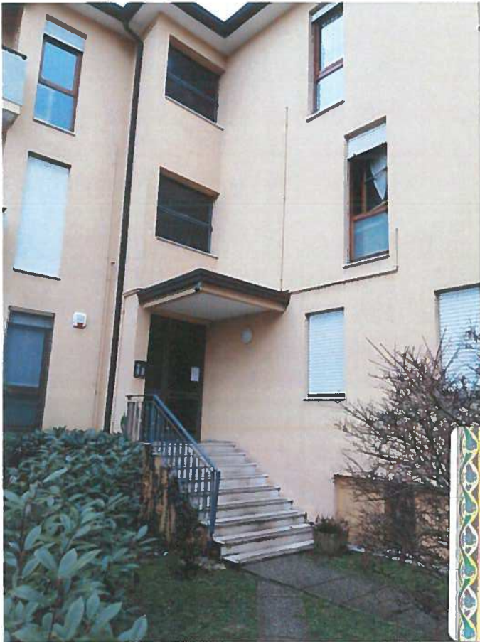
VISTA INGRESSO CONDOMINIALE
