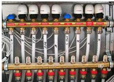
L'emissione del calore in ambiente avverrà mediante sistema radiante installato nel pavimento, il passo della tubazione sarà adeguata alla richiesta del locale.
