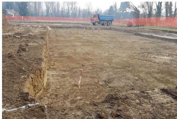
**Rinterro degli scavi** eseguito utilizzando il materiale proveniente dagli stessi e depositato nell'area di cantiere e/o utilizzando del materiale di riporto analogo.
