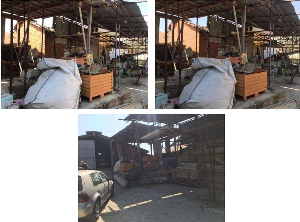
Trattasi di immobile (capannone) con accesso indipendente, elevato a un solo piano fuori terra, costruito con struttura portante in c.a., copertura in lastre di eternit. Finiture di tipo mediocre; lo stato di manutenzione è scarso paragonabile ad uno stato di abbandono.
