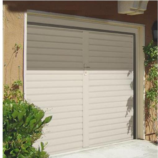
55. Fornitura e posa tra il garage e le parti comuni condominiali di **porta tagliafuoco EI 60** realizzata con doppia lamiera zincata e verniciata in tinta RAL 9018 (bianco papiro), con interposto materiale coibente ad alta densità, completa di cerniere, serratura a cilindro tipo Yale e maniglia antinfortunistica colore nero.
