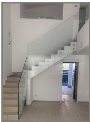
Le scale saranno realizzate con struttura portante in cemento armato e successivamente rivestite in gres porcellanato simile a scelta della D.L. con zoccolino di foglia di dimensioni adeguate.
