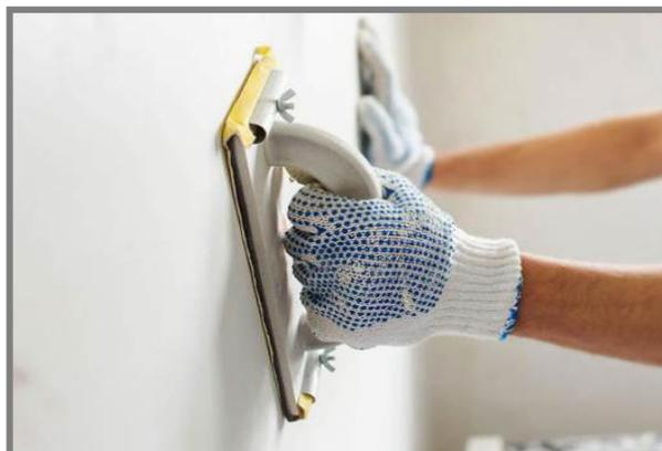
Tutti i locali di abitazione saranno rasati a gesso con materiale tipo "Roccia base cemento", sia per quanto riguarda le superfici orizzontali che le pareti verticali.
