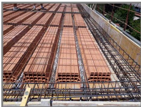
Tutti i solai saranno calcolati per un sovraccarico accidentale minimo adeguato alle normative vigenti e saranno realizzati in latero cemento del tipo tradizionale.
