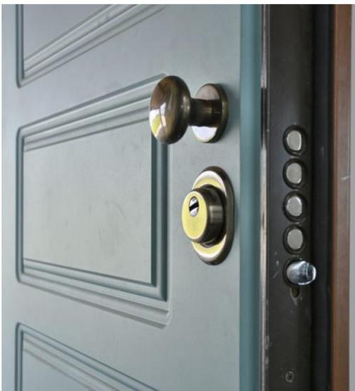
**Saranno di primaria marca nazionale, dimensioni cm 80 per un'altezza di cm 210 ,muniti di falso telaio in acciaio ancorato a struttura in acciaio fissata meccanicamente ai solai del fabbricato.**
