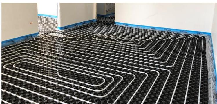
Il riscaldamento ambiente sarà effettuato con sistema radiante a pavimento, integrato da radiatori in acciaio a spalliera nei bagni. I termo arredi, con funzione anche di scalda salviette, saranno della marca Irsap colore bianco, completi di testina termostatica regolabile per il risparmio energetico. Si prevedono, per la regolazione della temperatura dei singoli ambienti, termostati che comandano le testine elettrotermiche di cui è dotato il collettore di distribuzione dei vari anelli radianti.
