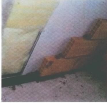
17. Tramezzi interni in blocchi forati da cm. 8 lavorati con malta mista, compreso il posizionamento di fettucce isolanti al piede delle tramezze, gli occorrenti ponteggi interni, la formazione di porte e ogni altro onere.
