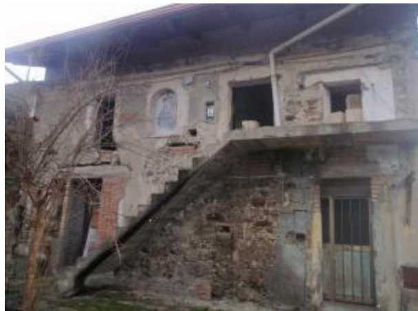
Foto 4 Vista del prospetto Sud del fabbricato
