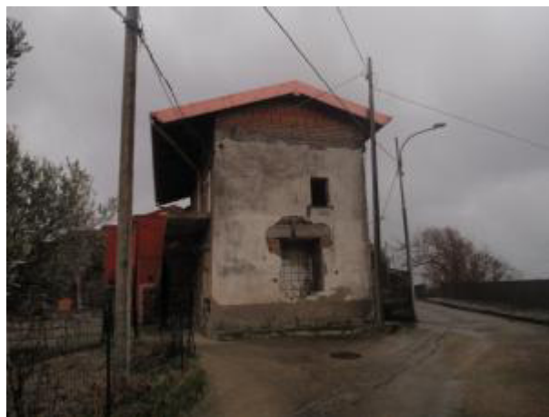
Foto 2 Vista del prospetto Est del fabbricato
