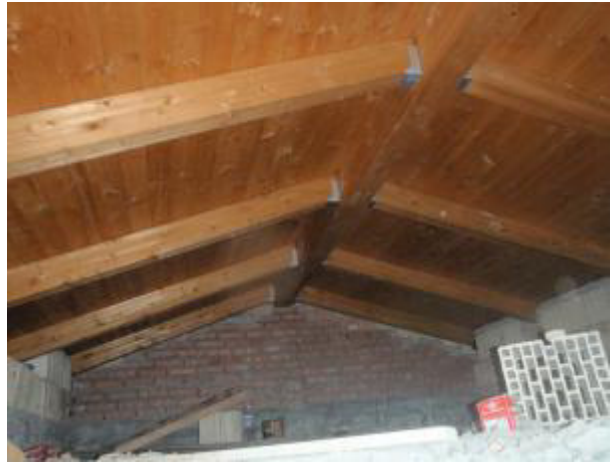
Foto 14 Vista degli interni, al P.1.
