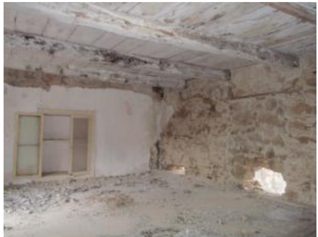
Foto 15 Vista degli interni, al P.1.
