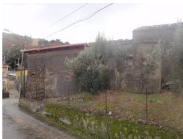
Foto 3 Vista del prospetto Nord del fabbricato
