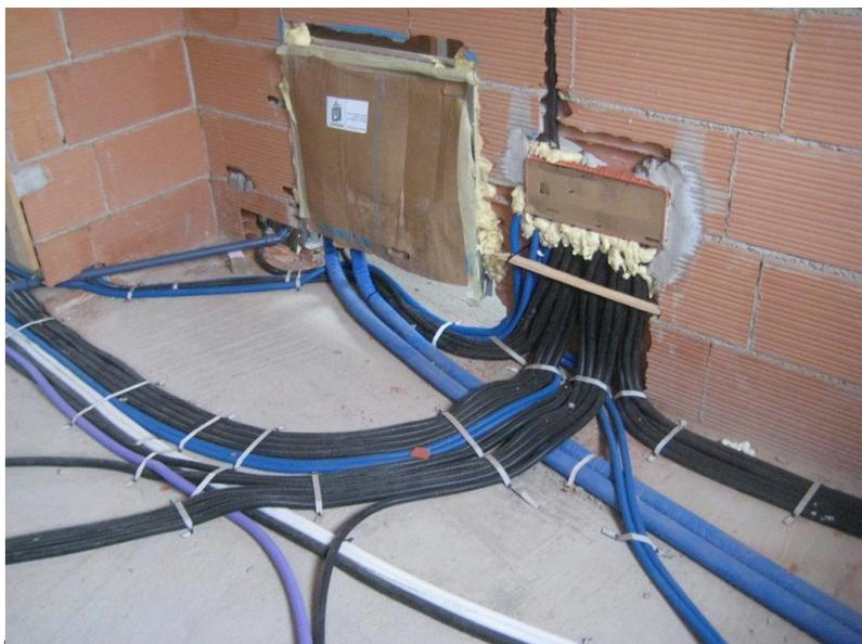
Ogni unità abitativa sarà dotata di impianto elettrico a doppio circuito (per corpi illuminanti e per elettrodomestici) costituito da condotti in tubo plastico incassato e conduttori in filo di rame isolato di adeguata sezione, realizzato secondo le vigenti normative.
