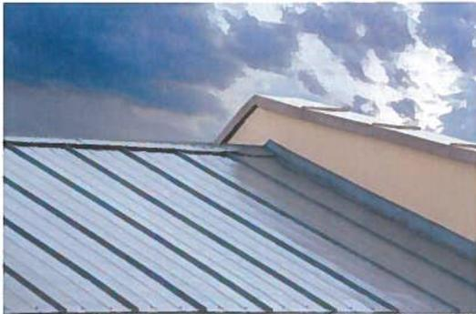
Manto di copertura realizzato con lastre grecate coibentate Tek 28 ottenute con processo produttivo in continuo spessore della lastra profilo Alubel 28 passo 112 mm, coibentazione in schiuma poliuretanic a cellule chiuse, applicata all'intradosso della lastra, spessore costante 10 mm a seguire la superficie geometrica della greca da posare e sormontare con sovrapposizione laterale pari ad una greca e mezzo.
