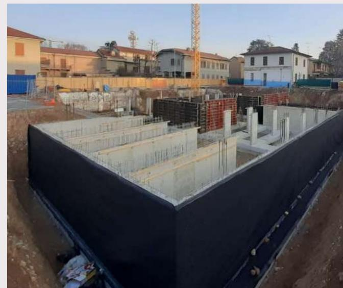
*Figura 10 – Impermeabilizzazioni eseguite in altro cantiere*
