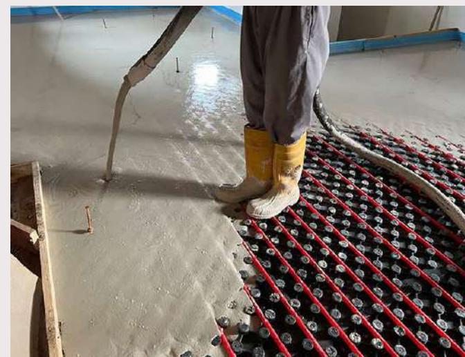
Figura 23 – Massetto radiante
