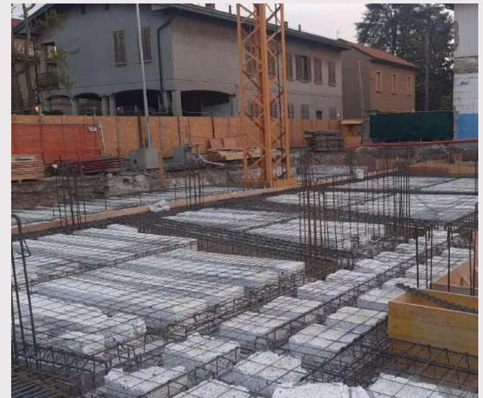
*Figura 8 – Solaio predalles realizzato in altro cantiere*
