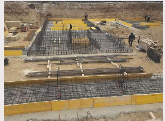
*Figura 7 – Opere in C.A. eseguito in altro cantiere*
