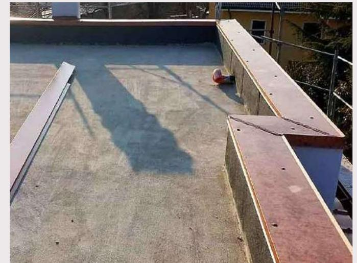
Figura 17 – Cappellotto in lattoneria coronamento copertura
