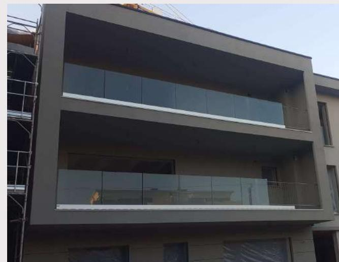
Figura 33 – Parapetti vetrati realizzati in altro cantiere
