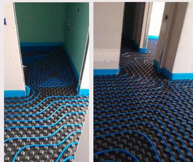
*Figura 38 – Impianto radiante realizzato in altro cantiere*
