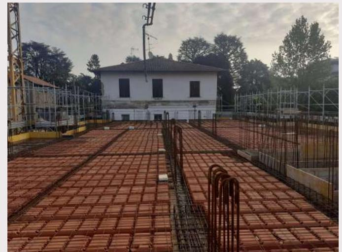
*Figura 9 – Solaio laterocemento realizzato in altro cantiere*
