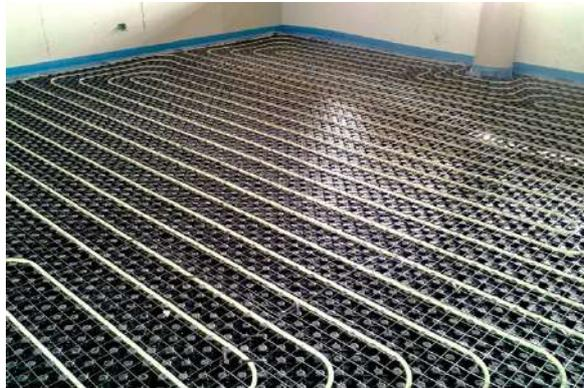
La costruzione sarà dotata di impianto di riscaldamento di tipo autonomo a pavimento a bassa temperatura con POMPA DI CALORE ad alto rendimento per la produzione di acqua calda sanitaria e riscaldamento e sarà abbinata ai pannelli solari che verranno installati sul tetto per la produzione di acqua calda sanitaria in ragione del 50% del fabbisogno pro-unità immobiliare (riferito a nucleo familiare di 4 persone con 2 bagni e in condizioni ottimali di esposizione).
