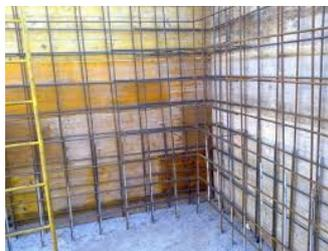
Tali armature sono adeguatamente protette da idoneo copriferro variabile a seconda del tipo di esposizione della struttura agli agenti degradanti.
