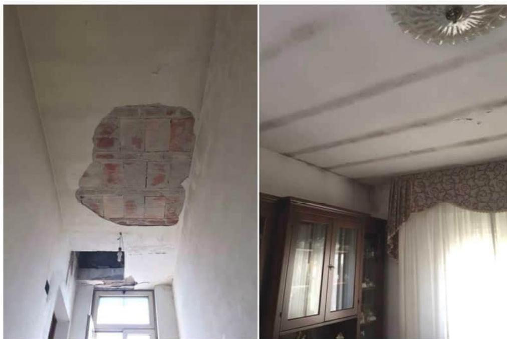
**Figura 9: Particolari infiltrazione d'acqua proveniente da copertura**
