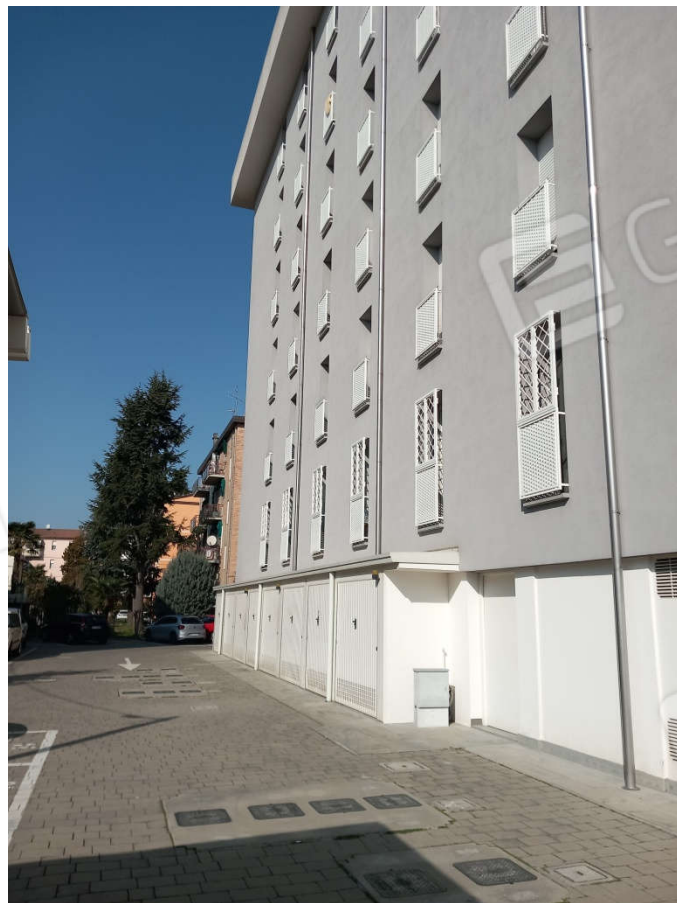
Foto n. 5 - Vista del prospetto posteriore del condominio
