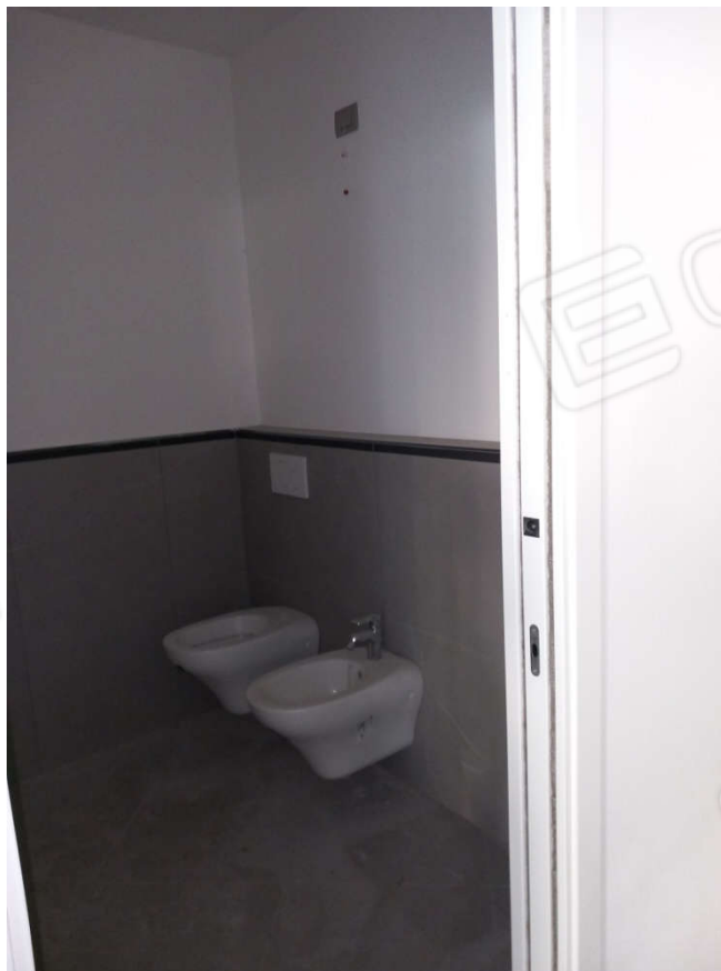
Foto n. 13 - Vista del bagno
