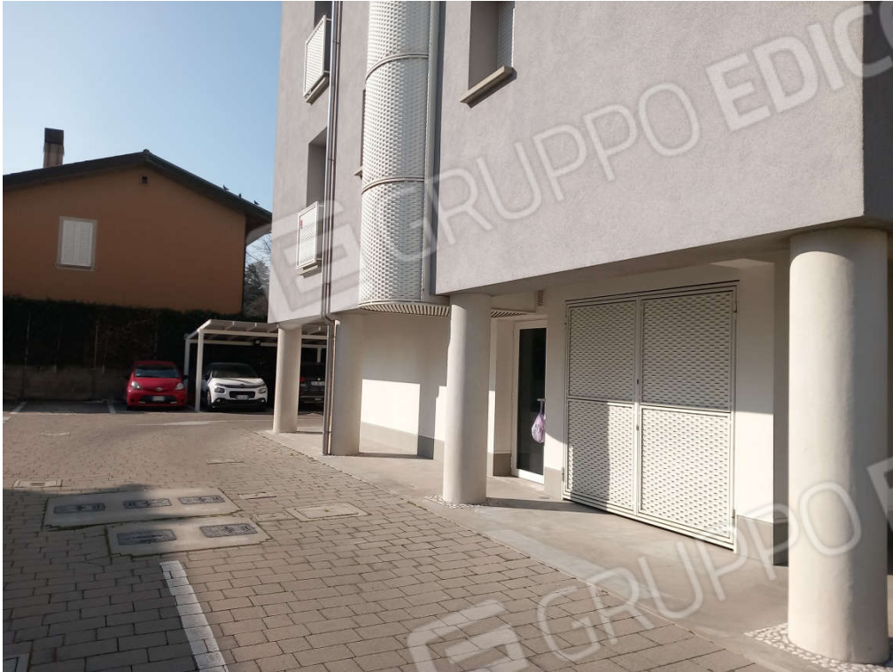
Foto n. 6 - Vista del prospetto laterale sinistro del condominio
