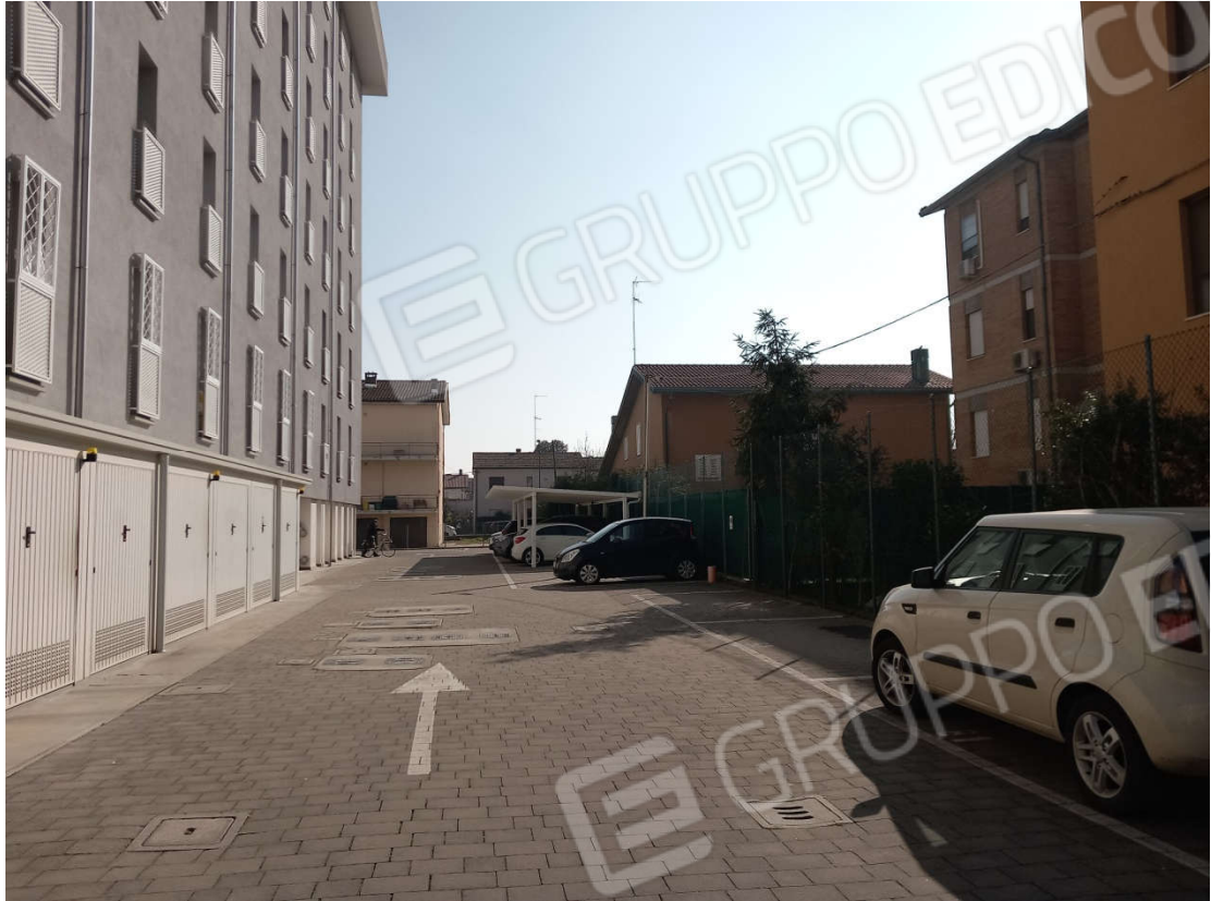
Foto n. 4 - Vista del prospetto posteriore del condominio
