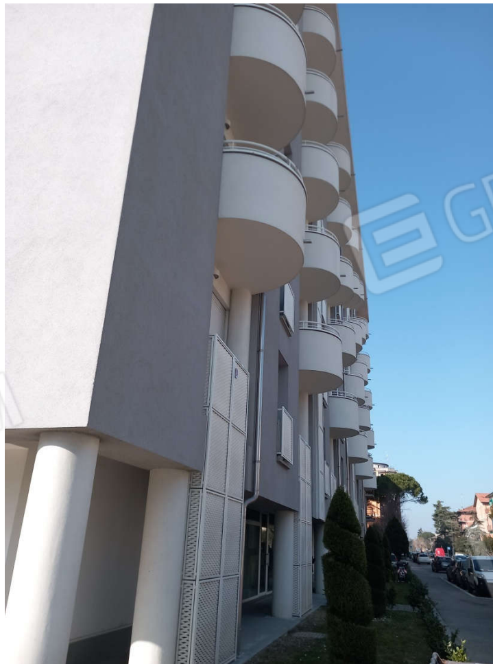
Foto n. 7 - Vista del prospetto frontale del condominio
