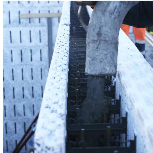
strato isolante del cassero ICF CLIMABLOCK, o simile, risulta continuo, costante ed omogeneo eliminando i ponti termici. Inoltre, la stratificazione della parete caratterizzata da isolamento – massa – isolamento consente di ottenere elevati valori di isolamento nei confronti del surriscaldamento estivo grazie alle elevate prestazioni in termini di sfasamento, smorzamento e trasmittanza della parete in cemento armato.
