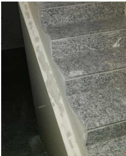
Le scale di collegamento tra il piano interrato ed il piano terra delle cinque villette poste all'interno del lotto, che per il loro sviluppo possono essere considerate "a schiera", saranno eseguite con una struttura in cemento armato, mentre il loro rivestimento sarà eseguito con degli elementi in pietra naturale, tipologia granito nazionale (serizzo o similari), con ringhiera in alluminio.
