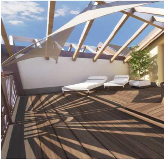
I pergolati riguarderanno solamente i terrazzi al piano secondo delle cinque unità immobiliari poste "a schiera" all'interno del lotto, e saranno composti da elementi costruttivi in legno di abete o pino giuntato (massello o lamellare), con superfici in vista piallate, di sezione rettangolare adeguata per pilastri, travi e travetti, compresi ogni singolo elemento occorrente all'installazione. Gli elementi dovranno essere trattati e tinteggiati.
