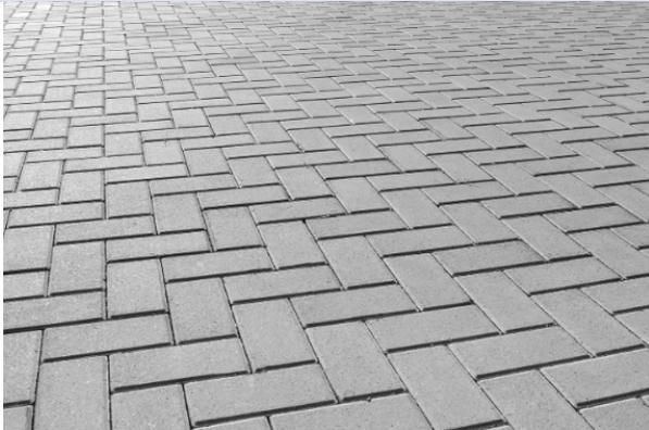
La pavimentazione esterna degli accessi e dei percorsi indicati nel titolo sarà eseguita con l'utilizzo di masselli di calcestruzzo vibrocompreso a doppio strato, resistenti al gelo, c.d. autobloccanti, finitura tipologia quarzo/porfido, previa stesura di riporto di sabbia fino ad un massimo di 5 cm. Dimensioni degli elementi 20x10 cm, spessore 6 cm.
