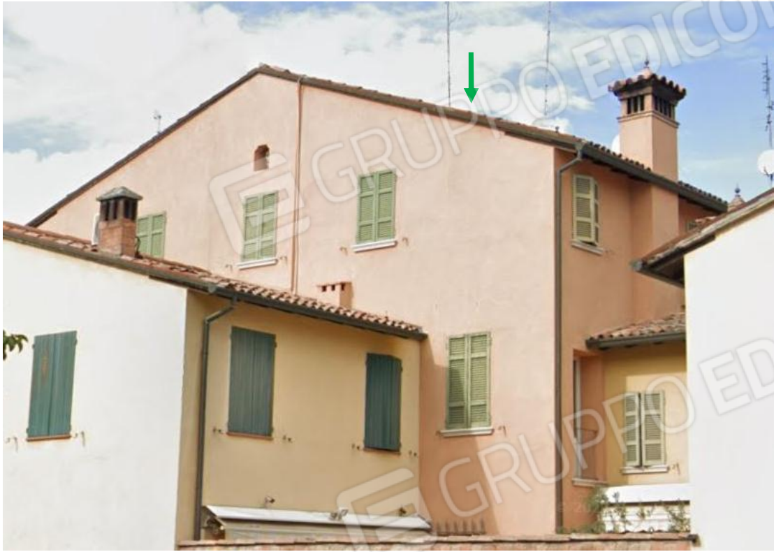
VISTA PROSPETTI EST E SUD DAL PARCHEGGIO DI VIA G.B. BASSI
