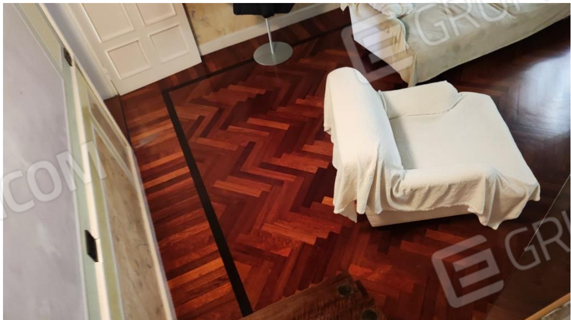
PARTICOLARE DEL PARQUET IN LEGNO A SPINA DI PESCE CON BINDELLO NEL LOCALE SOGGIORNO
