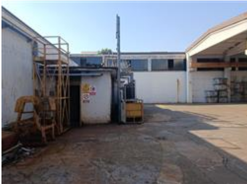
Vista da cortile interno
