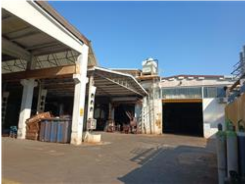
Vista da cortile interno
