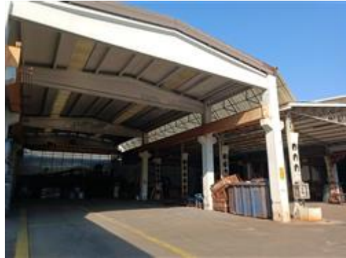
Vista da cortile interno
