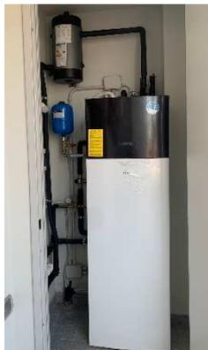
L'impianto di climatizzazione, riscaldamento e ACS sarà a pompa di calore del tipo individuale per ogni appartamento. Caratteristiche principali:
