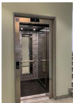
L'impianto ascensore di primaria marca (Kone, Schindler) sarà con motori elettrici silenziosi a basso consumo del tipo senza locale macchine con le seguenti caratteristiche:
