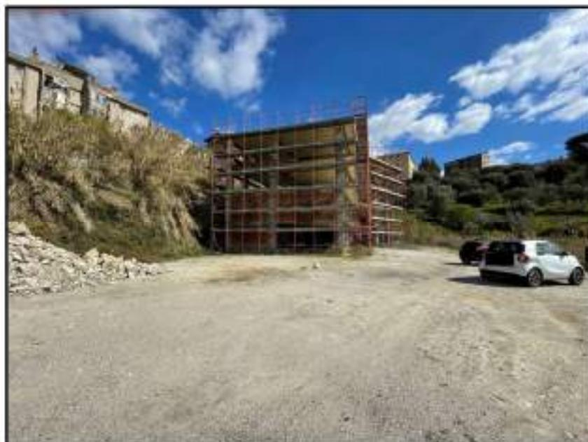
I lavori per il completamento della costruzione, che è asservita da un ponteggio metallico a telaio lungo tutte le facciate, risultano sospesi in fase di realizzazione delle tamponature esterne, delle quali è stata realizzata solo una piccola porzione ai primi due livelli.
