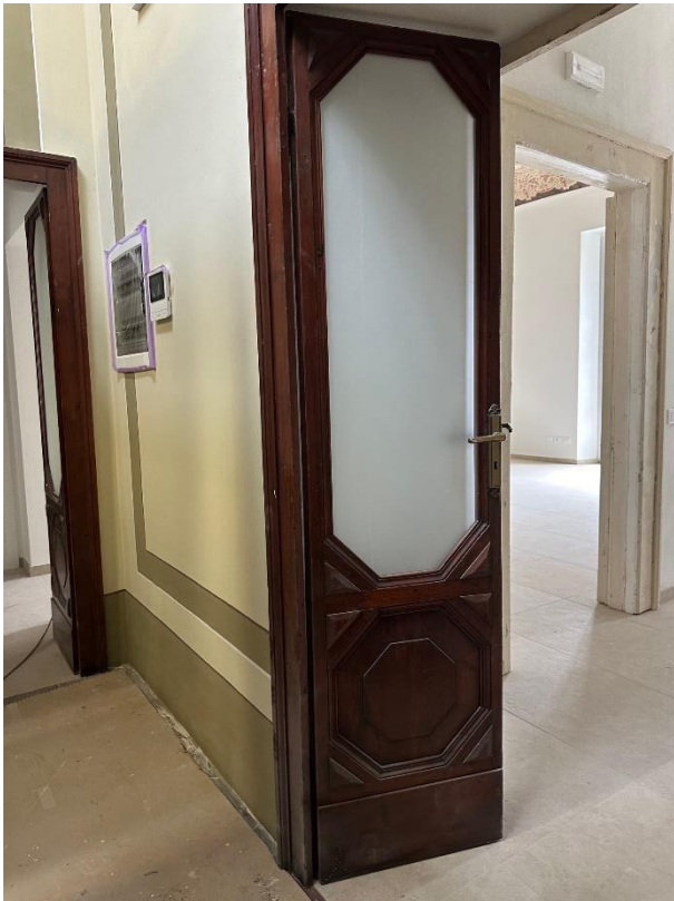
Disimpegno Piano Primo
