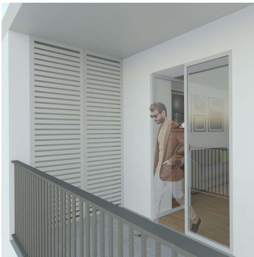
L'impresa ha progettato una struttura in alluminio composta da due ante con lamelle fisse, finitura colore bianco, a copertura delle macchine esterne presenti sui balconi del cortile interno.
